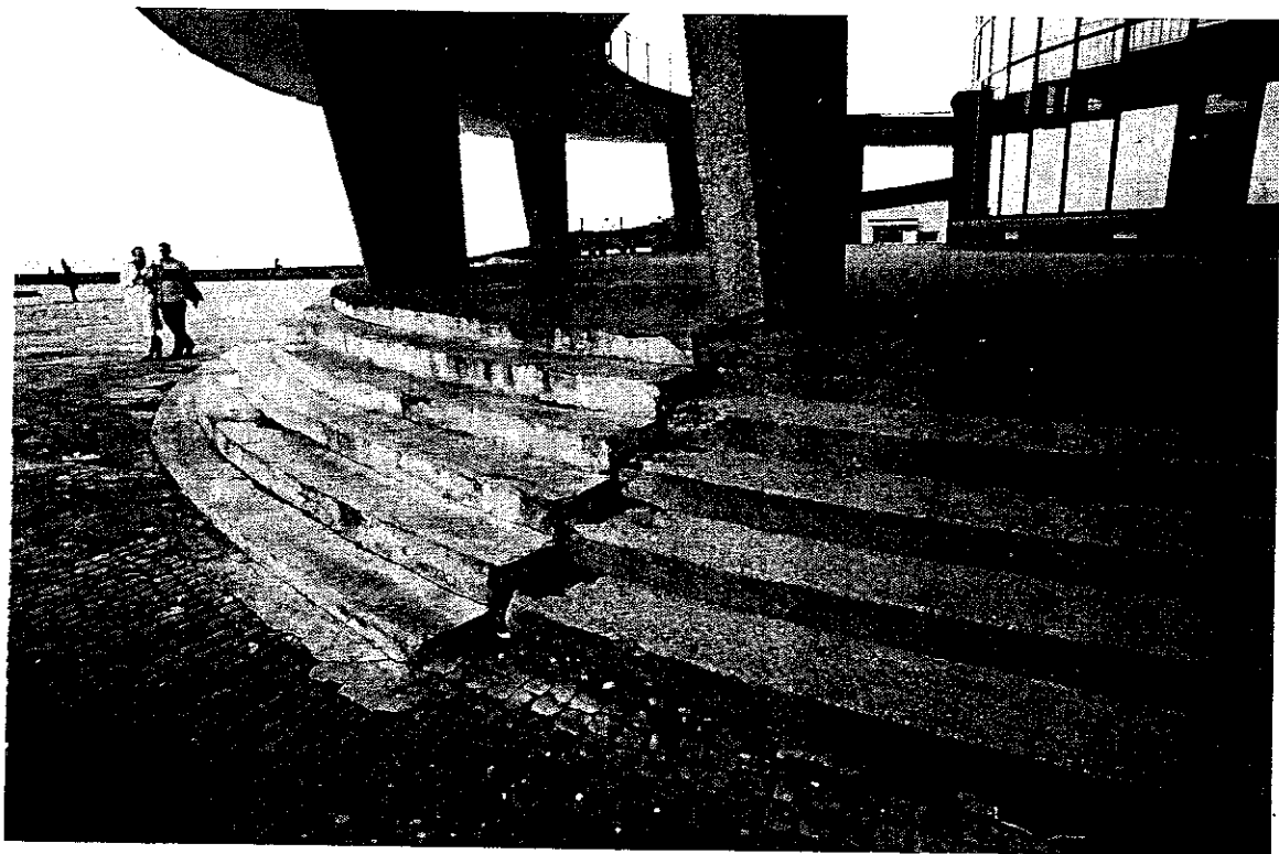
Fot. 7. Część płn. – wsch. obiektu. Widoczny niechlujnie wykonany styk wybudowanych w różnym okresie schodów zewnętrznych.
