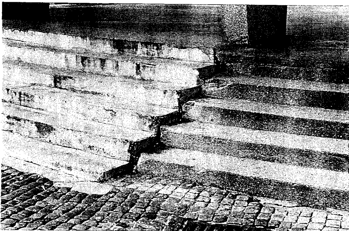
Fot. 8. Szczegół z fot. 7. Bruk pod schodami wyraźnie zdeformowany.
