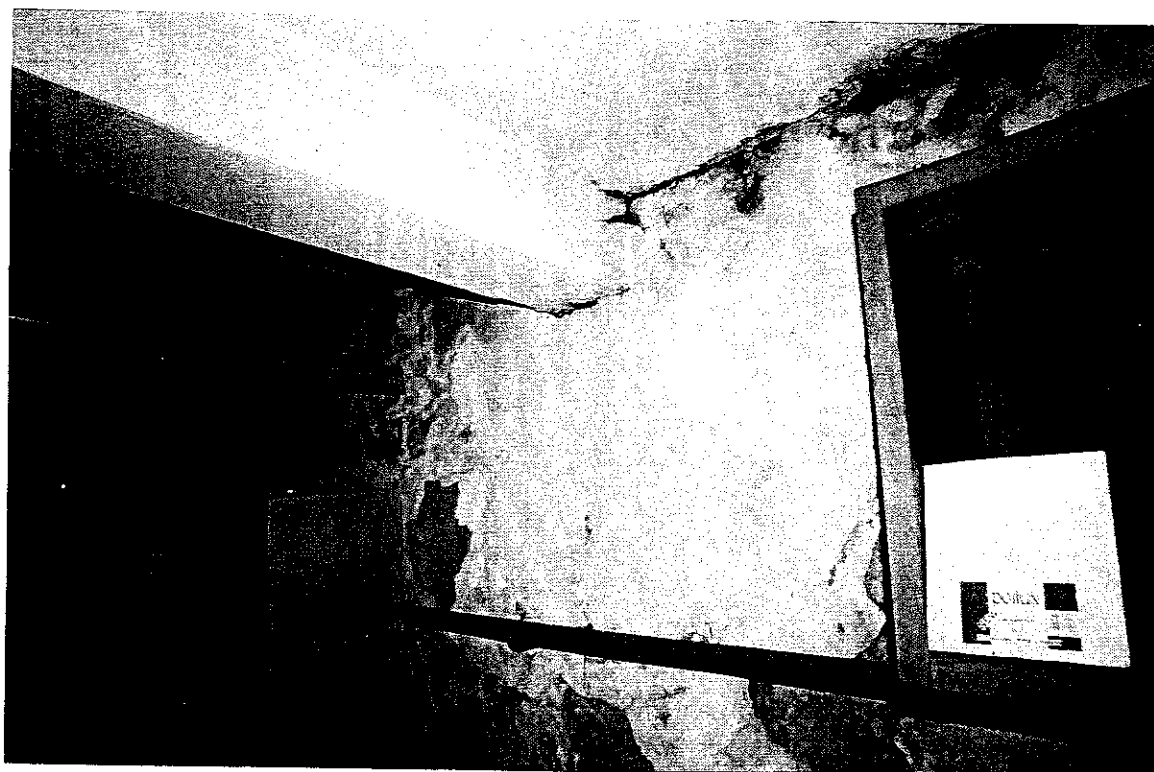
Fot. 22. Widok na ścianę zewnętrzną budynku – kontynuacja fot. 21.
