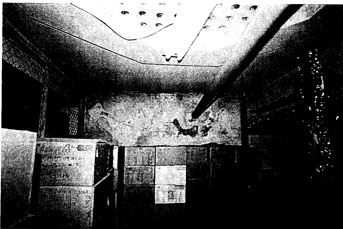
Fot. 21. Pomieszczenie magazynowe w części północnej obiektu. Rozległe zacieki i wykwyty soli na zewnętrznej ścianie budynku.
