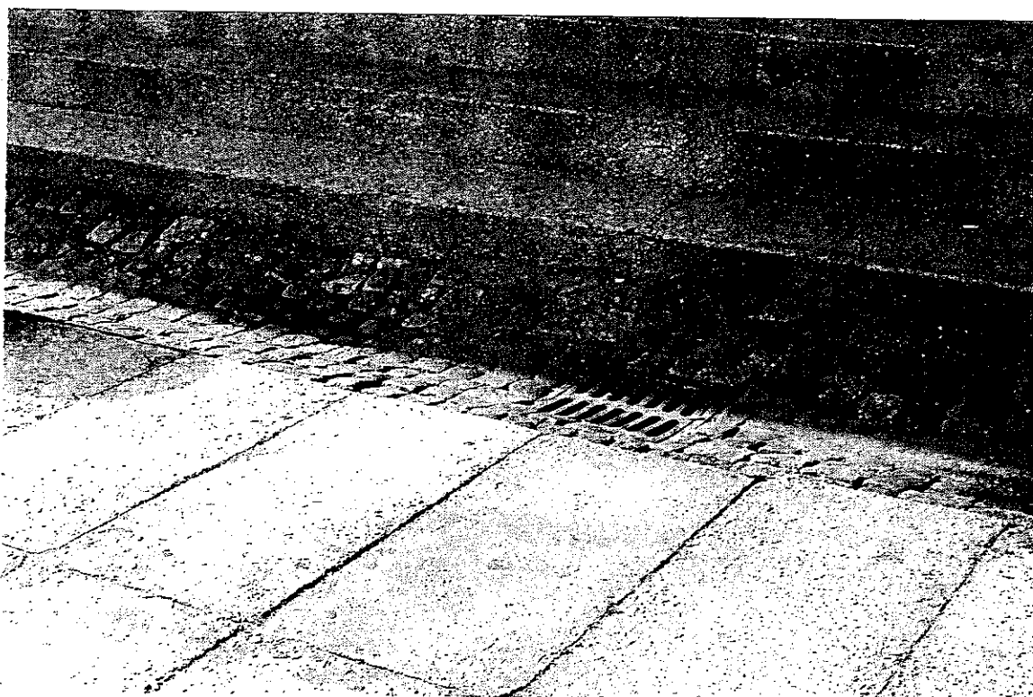
Fot. 3. Wyraźnie zdeformowana kamienna powierzchnia odwodnienia w pobliżu wpustu do kanału deszczowego.
