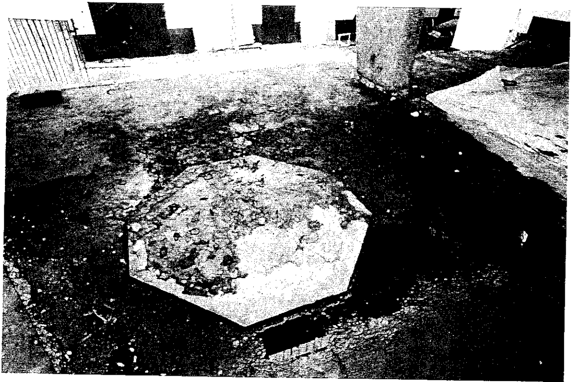
Fot. 11. Zdjęta nawierzchnia nad południową częścią budynku. Widoczny dawny świetlik nad помещением przyziemia.
