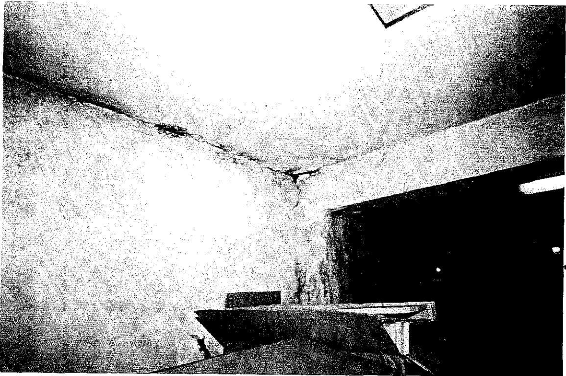
Fot. 17. magazyn w części północnej obiektu. Widok na pokrytą wysoleniami i pleśnią zewnętrzną północną ścianę magazynu.
