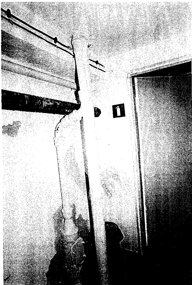
Fot. 27. Pomieszczenie pod windą. Dołem widoczna betonowa (żelbetowa) ściana fundamentowa. Po lewej niedawno ustawiony fundament pod silnik widny.
