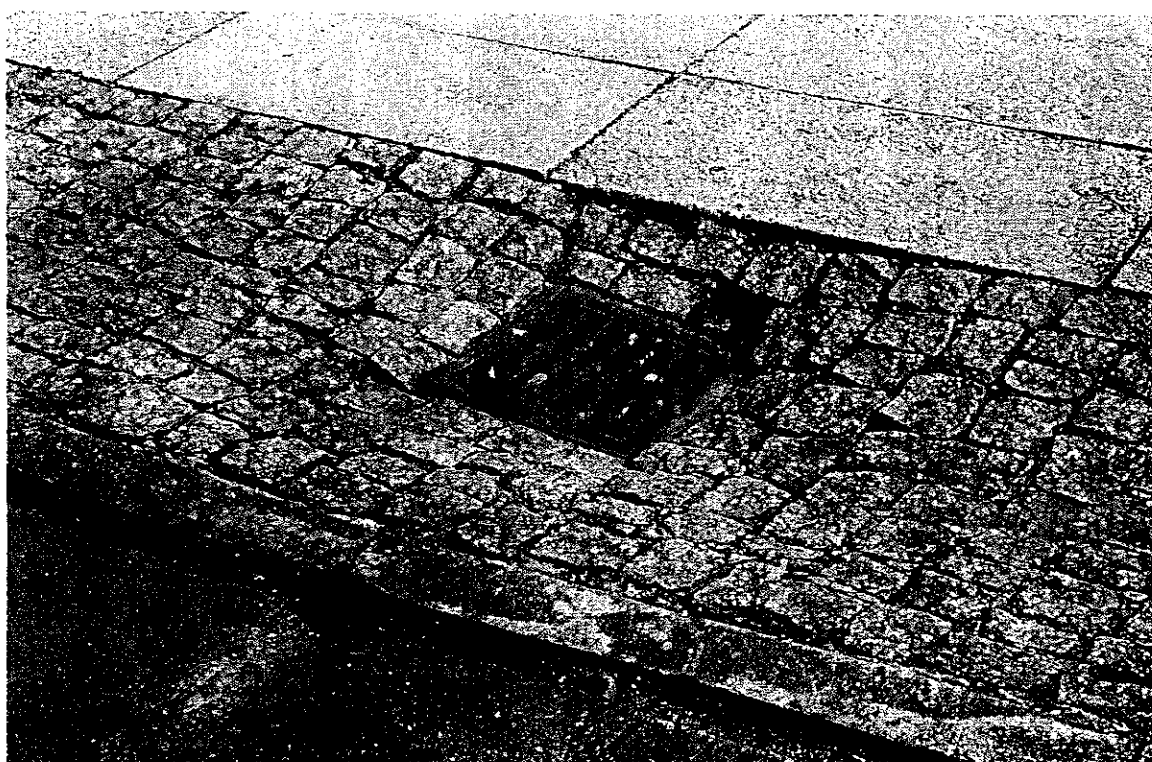
Fot. 4. Wpust kanału deszczowego wyraźnie zapadnięty.
