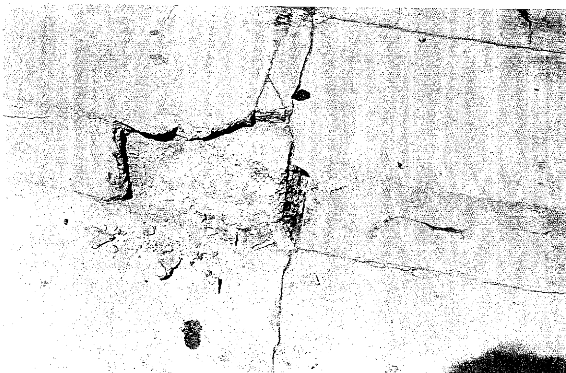
Fot. 10. Detal z fot. 9. Widoczne odspajanie się betonowej powierzchni stopni oraz butwiejące drewno w szczelinie dylatacyjnej.
